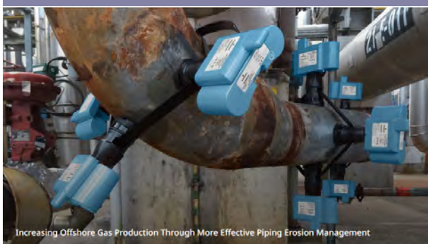
Rosemount ワイヤレス 腐食・エロージョン監視システム センサー設置例 注)
